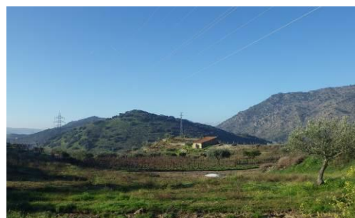
Fotografia 29 - Linha eléctrica da EDP existente onde se fará a ligação do Parque Eólico
