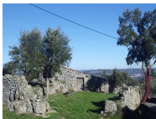
Fotografia 41 - Ruínas existente no núcleo Este
